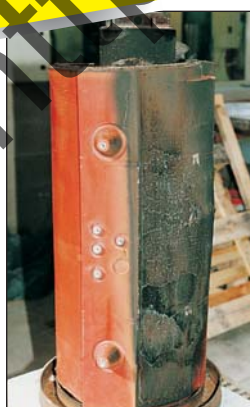
Катушка трансформатора Trihal после испытания F1
